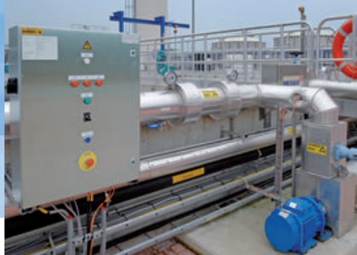
Die Neutralisation mit flüssigem Kohlendioxid erfolgt auf kleinstem Raum.
