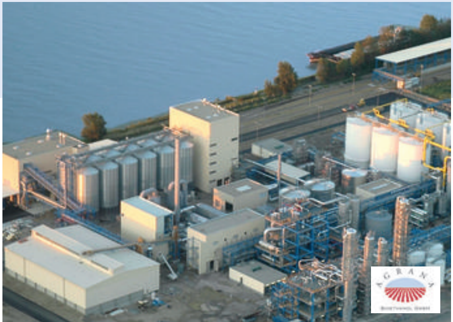
In einer der größten Bioethanolanlagen Europas in Pischelsdorf, Österreich, sorgt Stickstoff von Messer für eine explosions-sichere Produktion.
