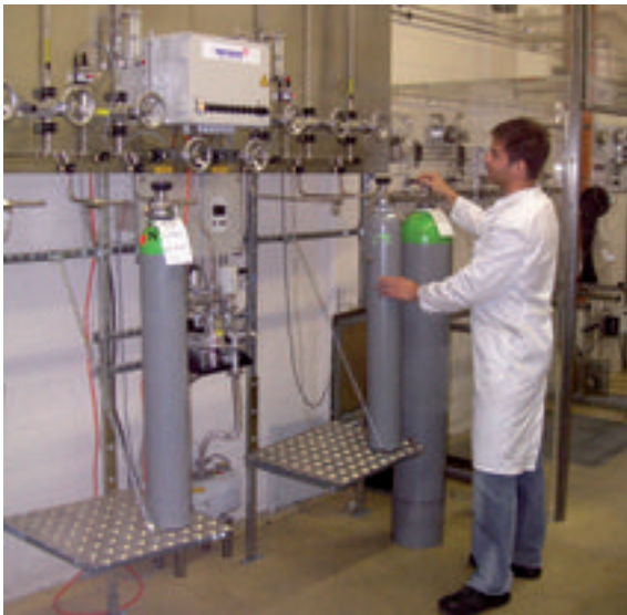
Abfüllanlage in Lenzburg, Schweiz
