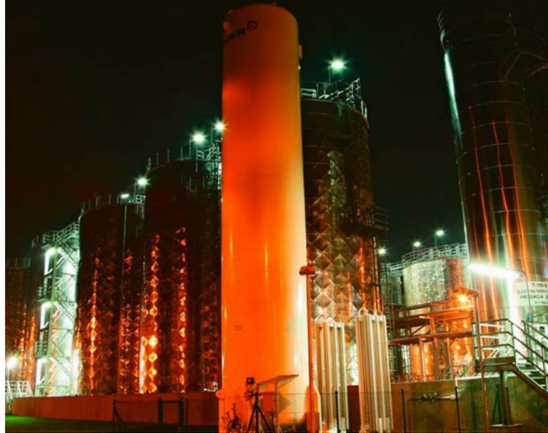
In Trzebinia, Polen, steht die erste Bio-Diesel-Anlage Zentral- und Osteuropas. Stickstoff von Messer sorgt hier für die Produktion und Lagerung des Kraftstoffs notwendige Inertgasatmosphäre.
